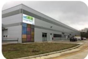
Sistem Fotovoltaic integrat în anvelopa clădirii
